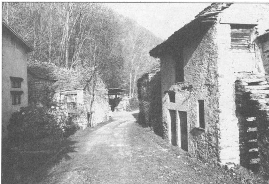
fig. 1 : Tratto di strada circolare abbandonato attraverso il nucleo di Cassina nel comune di Gorduno. foto IVS: Giorgio Bellini.
