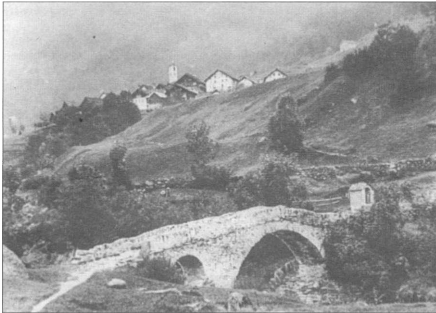
fig. 3: Il ponte della mulattiera di Piana Selva sotto Cornone in una foto d'inizio secolo rintracciata da Mario Fransioli. Il ponte fu distrutto da una piena della Piumogna negli anni Trenta. Di quell'antica costruzione è rimasta solo la spalla sinistra con la cappella. La sua struttura è molto simile a quella dei due ponti di Giornico.
