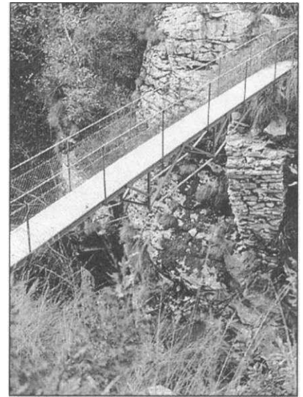
fig. 1: Il resto di ponte sul Riale di Drosina nella Valle di Lodrino, lungo il sentiero che collega Pönn a Lègri. Sotto la passerella è ben evidente l'imponente spalla in sasso. Foto IVS: Massimo Colombo.
